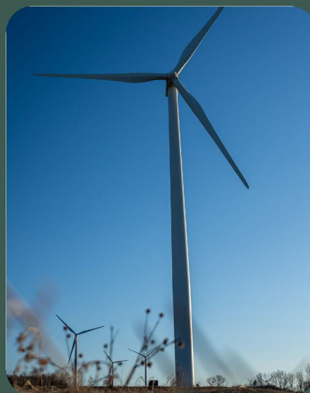
Parc éolien Innergex (Québec)
